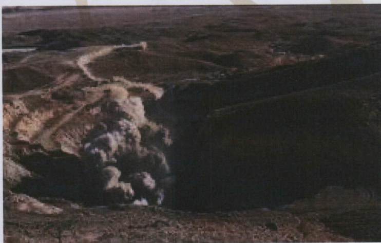
عکس انجام عملیات آتشیاری
